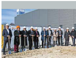
Das Startsignal für den neuen Fertigungs- und Bürotrakt: Am 5. März erfolgte der erste Spatenstich durch Vertreter von Emag, der Baufirmen sowie der Politik.
